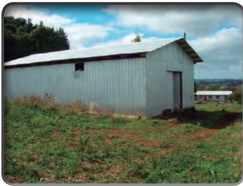
Foto 1. Bodega de almacenaje pequeña con ventilación natural superior
