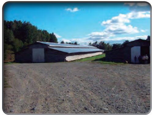
Foto 2. Bodega de almacenaje con ventilación natural superior e ingreso de aire a ras de suelo
